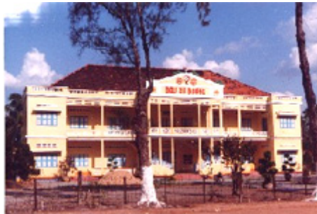
*Hình: Đâu Sư Đường
