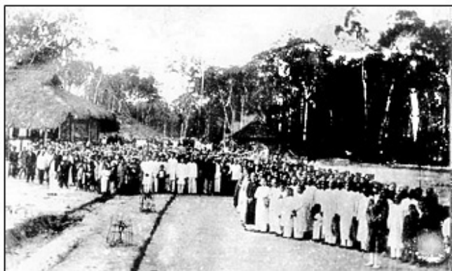
LỄ KHỞI CÔNG XÂY CÁT TÒA THÁNH
