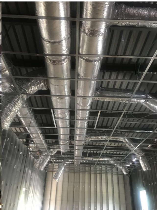
Hệ thống ống và máy lạnh, nóng đã lắp đặt
