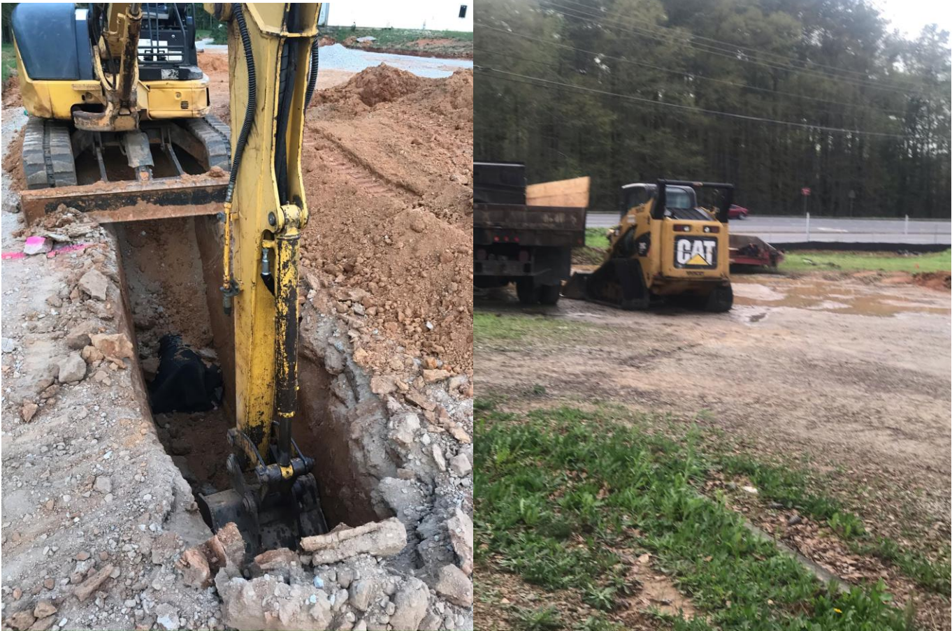
Đoàn cơ giới đang đào mương, đặt cống và san lấp mặt bằng để làm Paking.
