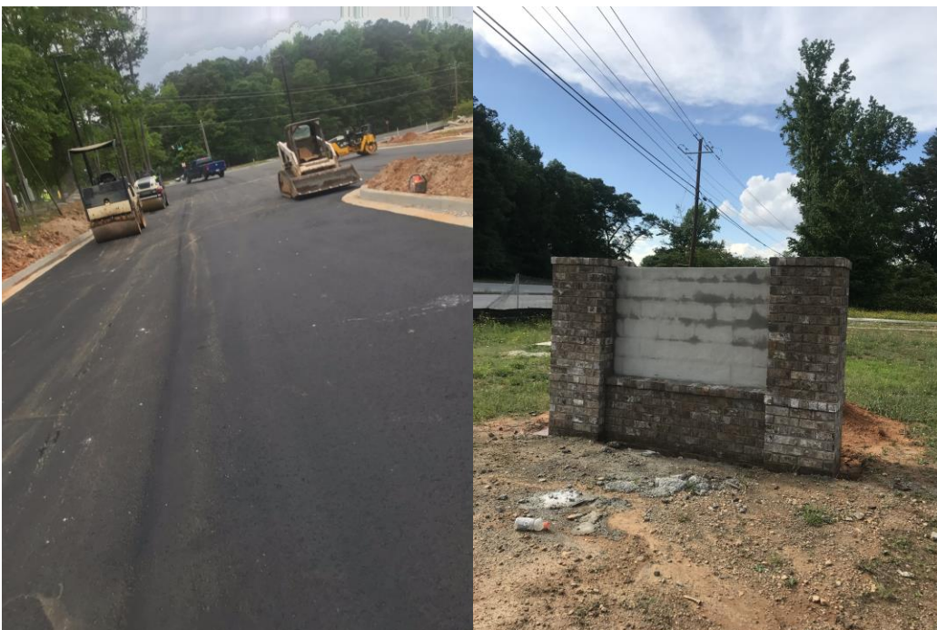
Parking đã hoàn thành được hơn 70 chỗ
