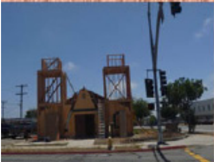
Thánh Thất lúc sửa chữa
