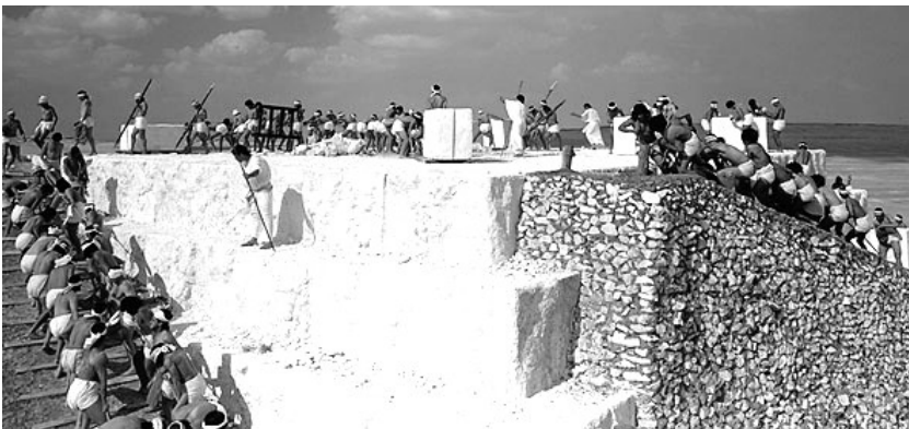
Ảnh mô phỏng việc xây dựng kim tự tháp của các nô lệ.
