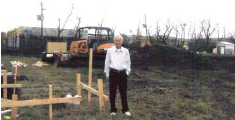
Đóng khung chuẩn bị xây Hậu Điện
