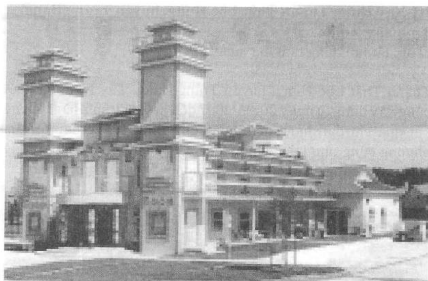
Thánh Thất đang xây tại 1851 Apollo Road, Garland , Texas 75044 ( Hình chụp tháng 05-2009)
