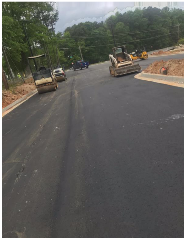
Parking hơn 70 chỗ đã hoàn thành
