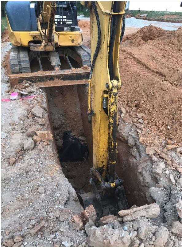
Đào mương - Đặt cống - San lấp mặt bằng để làm Parking
