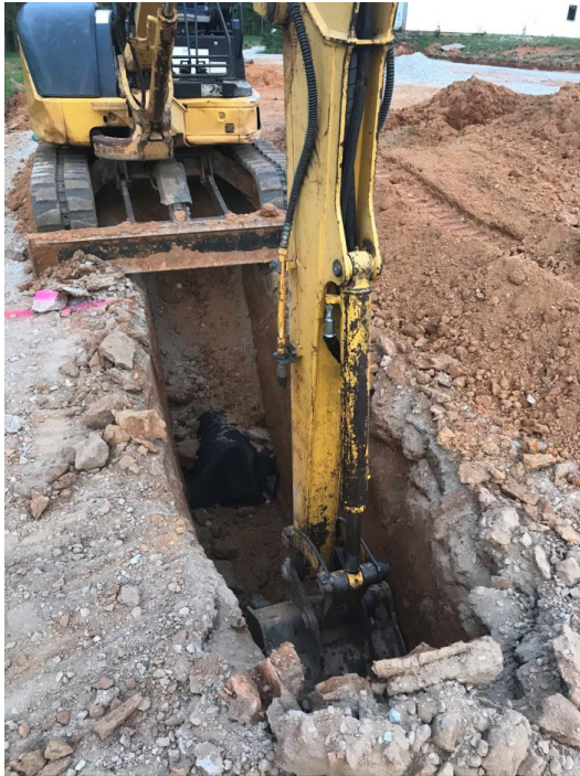
Đào mương - Đặt công
