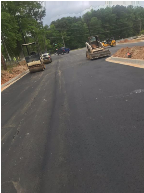
Parking 70 chỗ đã hoàn thành
