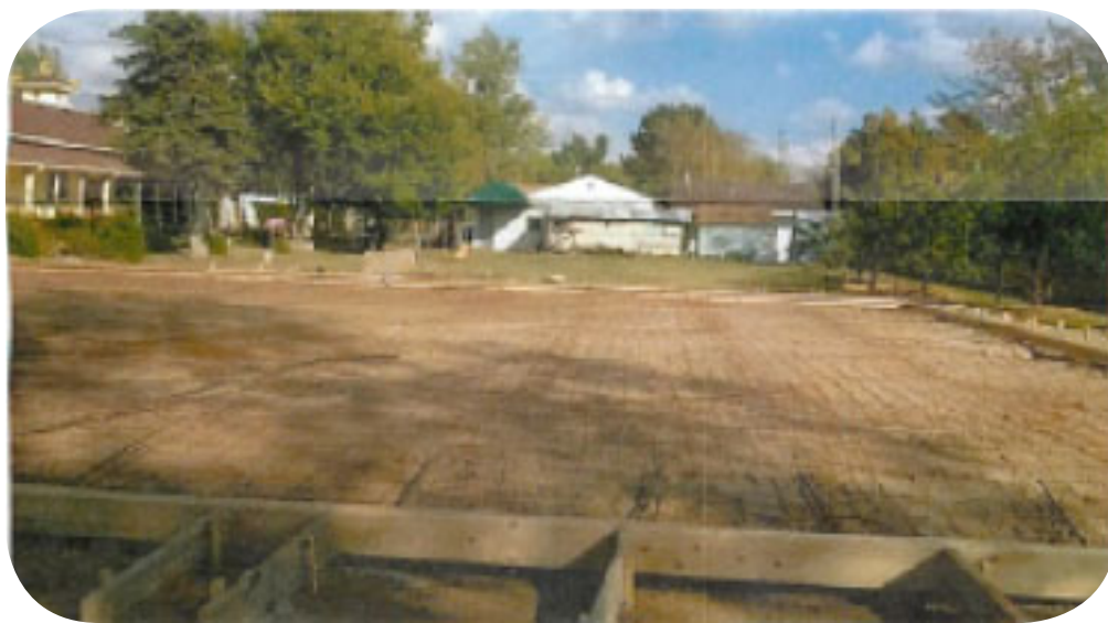
Nền móng Hội Trường chuẩn bị đổ bê tông 120 feet dài, 40 feet rộng
