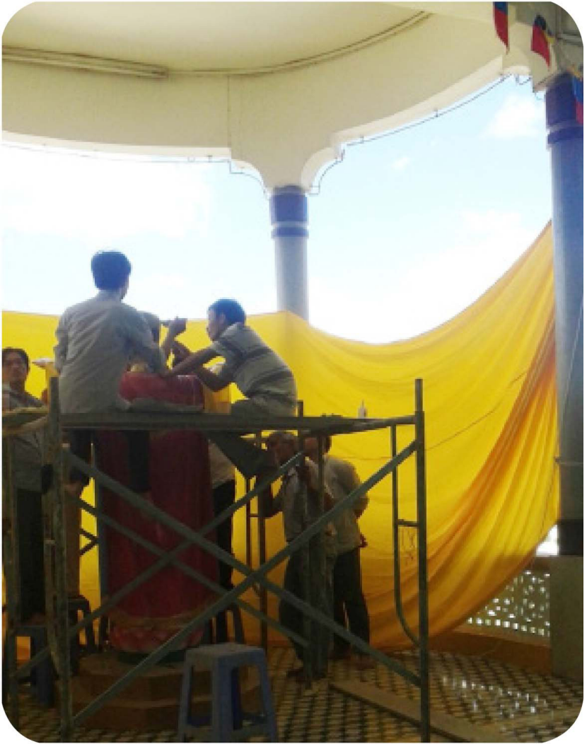
Thợ đang sửa chữa tượng
