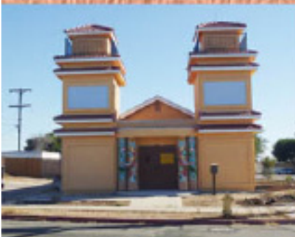
Thánh Thất San Diego CA sửa chữa xong
